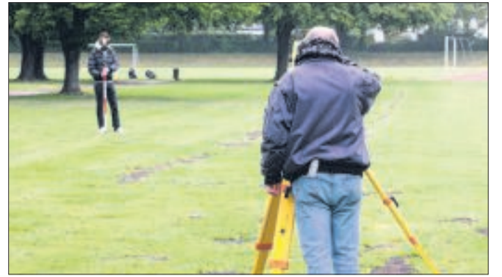
Für die Förderanträge beim Land NRW müssen Baupläne eingereicht werden. Hier tritt das Besselgymnasium in Vorleistung. Das Gelände neben der alten Sporthalle wurde bereits vermessen. MT-Foto: Riechmann
